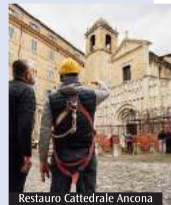
Restauro Cattedrale Ancona
