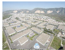
A sinistra, il viale d'accesso al Centro Ingresso Sviluppo (Cis). In basso, una veduta aerea del Cis
