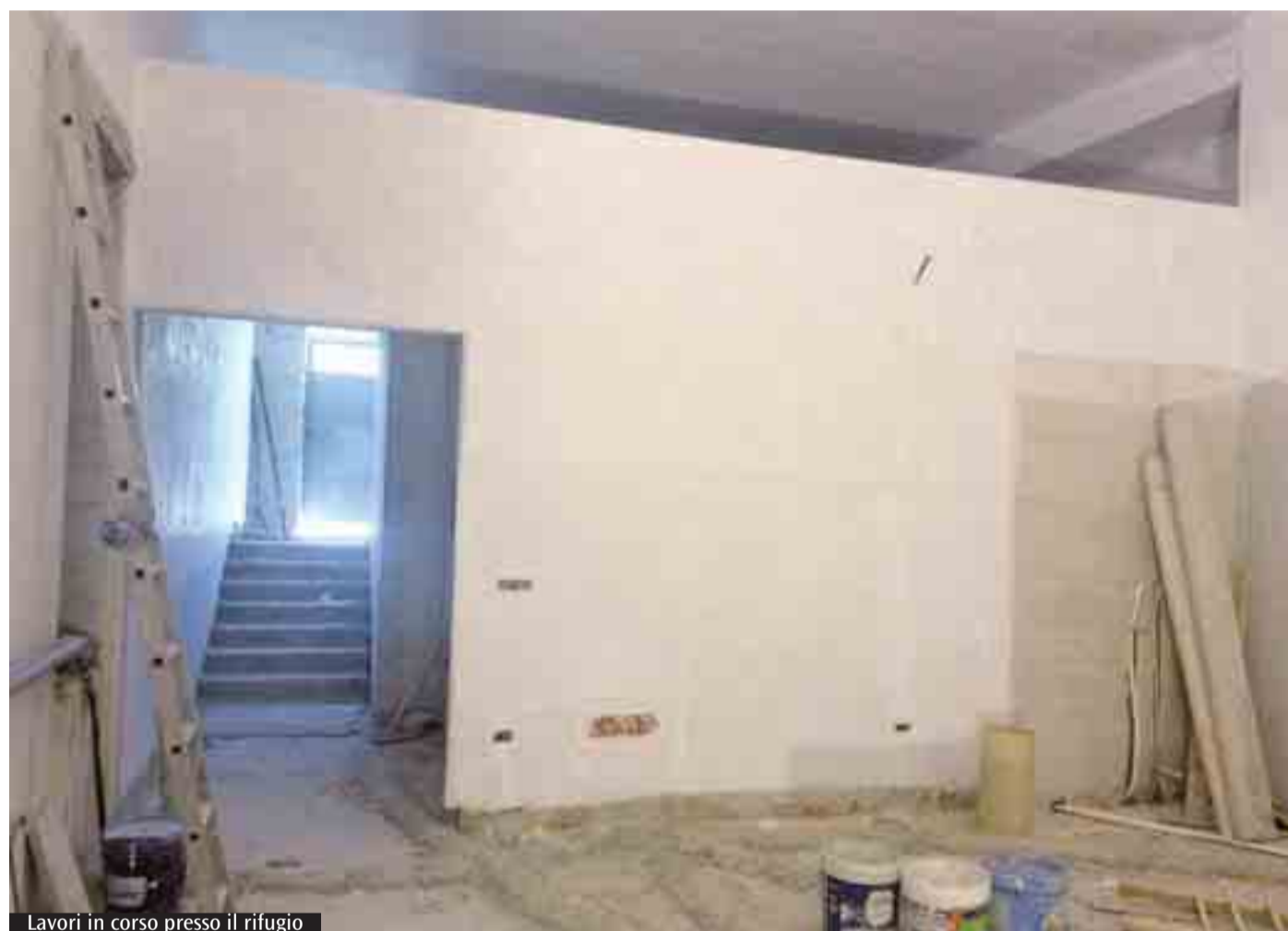
Lavori in corso presso il rifugio
